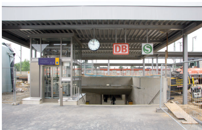
Neue Konzepte sollen das Sicherheitsgefühl im neuen Bahnhofs-tunnel verbessern.
