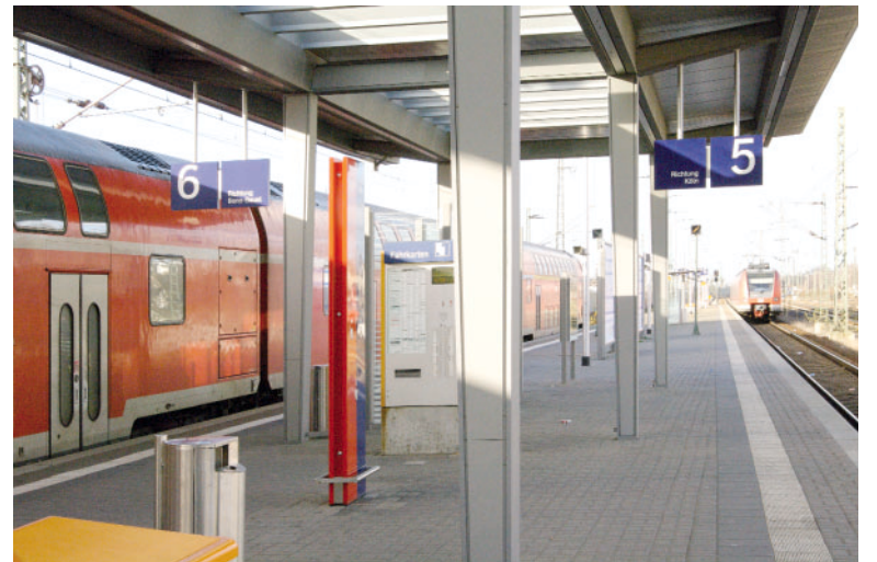
Weitgehend abgeschlossen sind bereits die Umbauarbeiten an den Gleisen 5 und 6.
