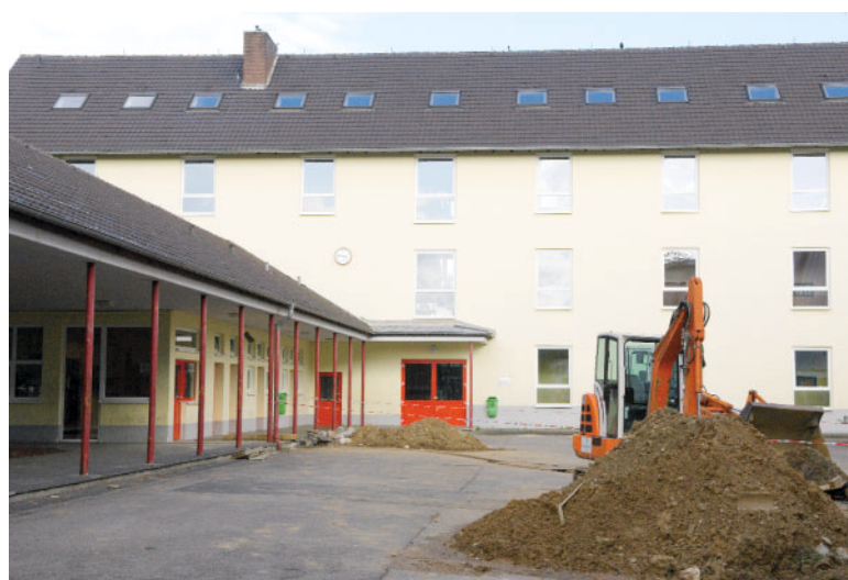
Renovierungsarbeiten an der Hauptschule Lohmarer Straße.
