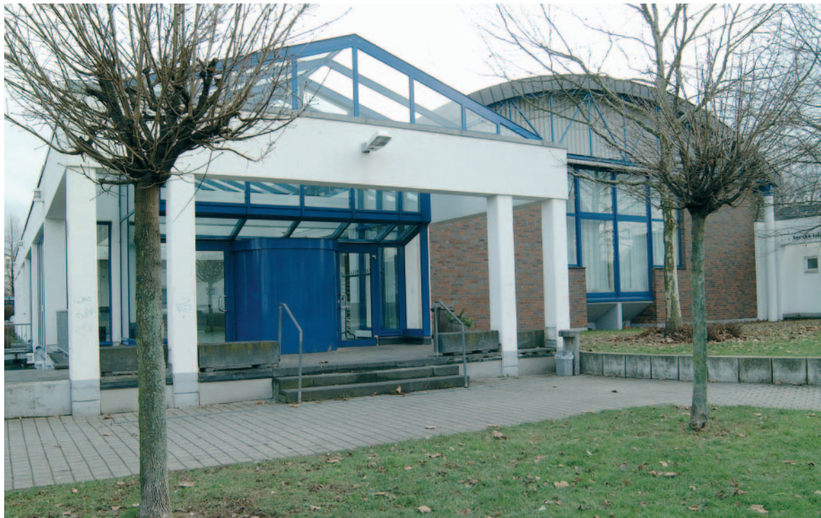
Auch das Foyer der Mehrzweckhalle in Friedrich-Wilhelms-Hütte wird eine Klimaanlage erhalten.
