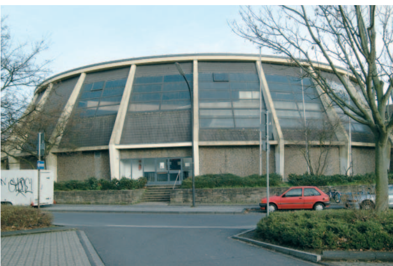
Dringend sanierungsbedürftig ist die Rundturnhalle am Elsenplatz.
