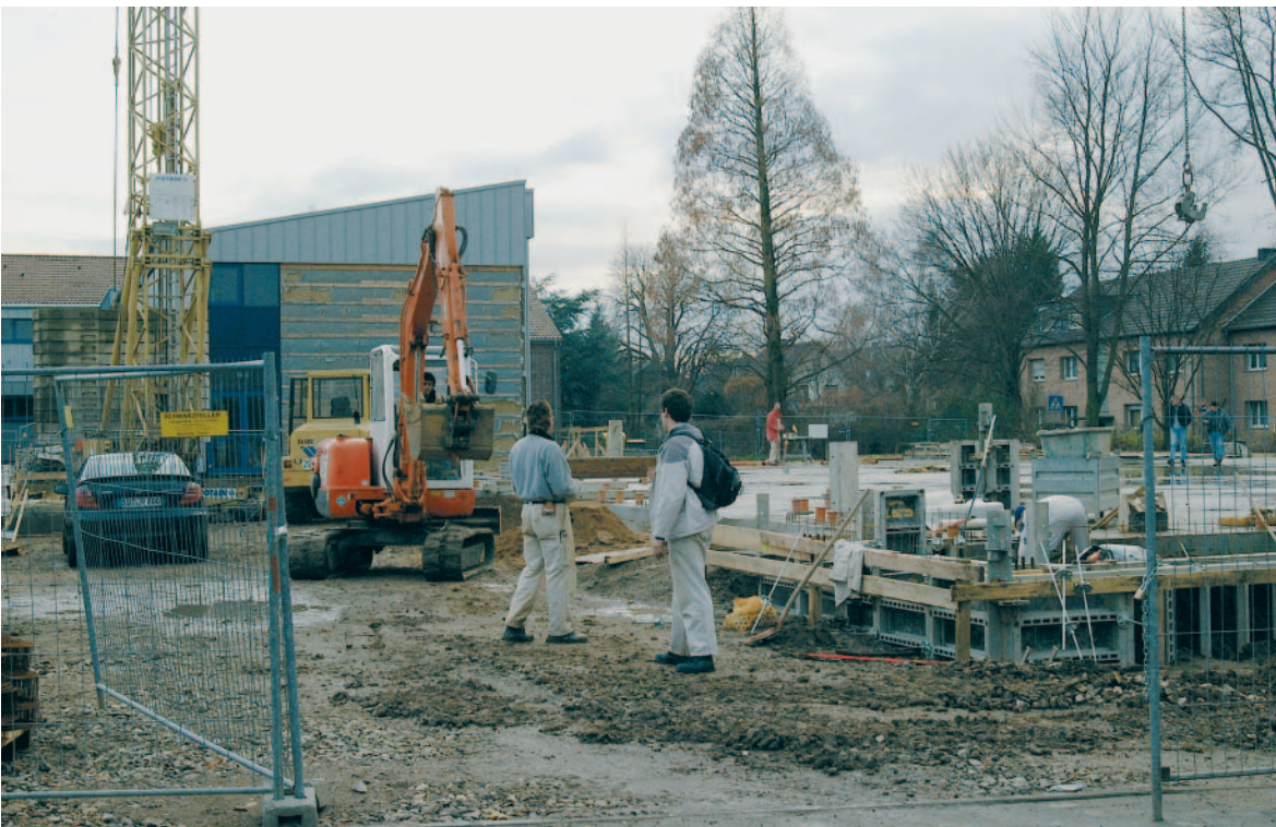
Täglich wächst die neue Mehrzweckhalle für Bergheim an der Glockenstraße.
