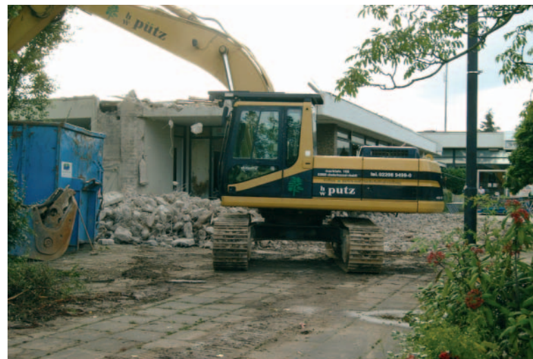
Gut voran kommen die Bauarbeiten zum Zentralen Omnibusbahnhof.
