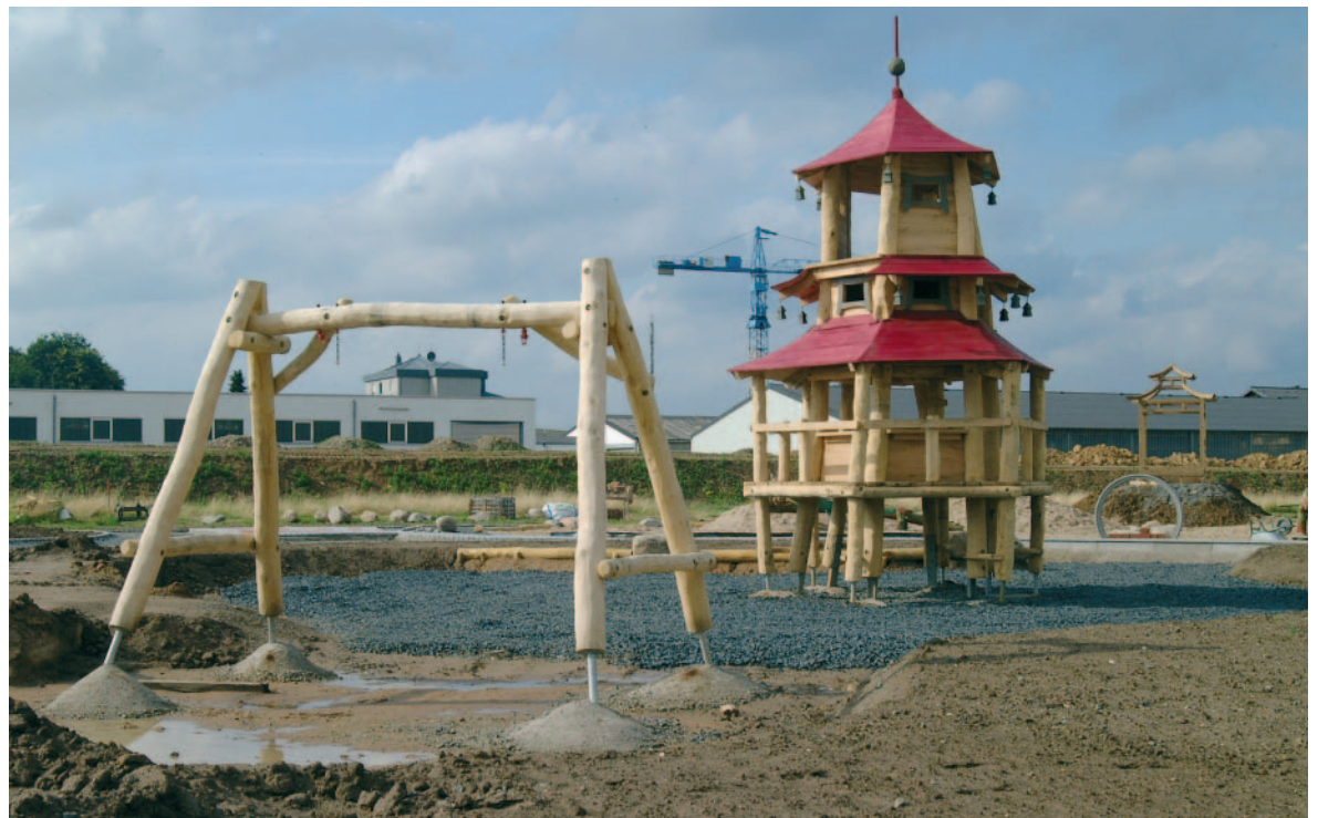
Kräftig gebaut wird noch am Spielplatz Maarstraße, der in wenigen Wochen fertiggestellt wird.
